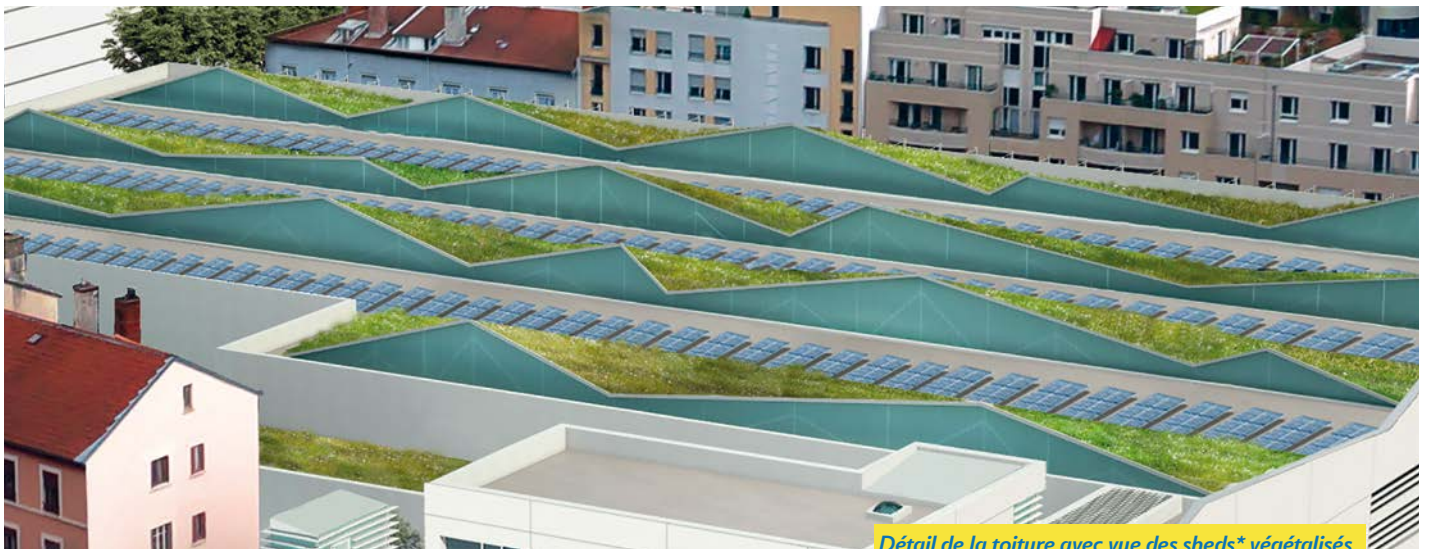
Détail de la toiture avec vue des sheds* végétalisés et des panneaux photovoltaïques.
